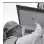
見回り時の目視点検の様子
