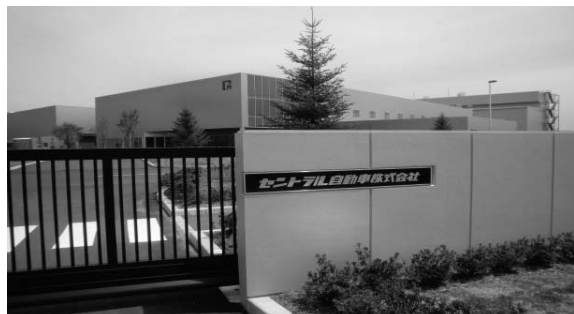
平成23年1月本格稼働の完成自動車製造新工場
