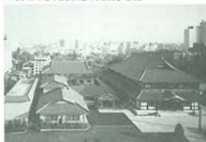
▲高輪変電所の上に建つ高野山東京別院
