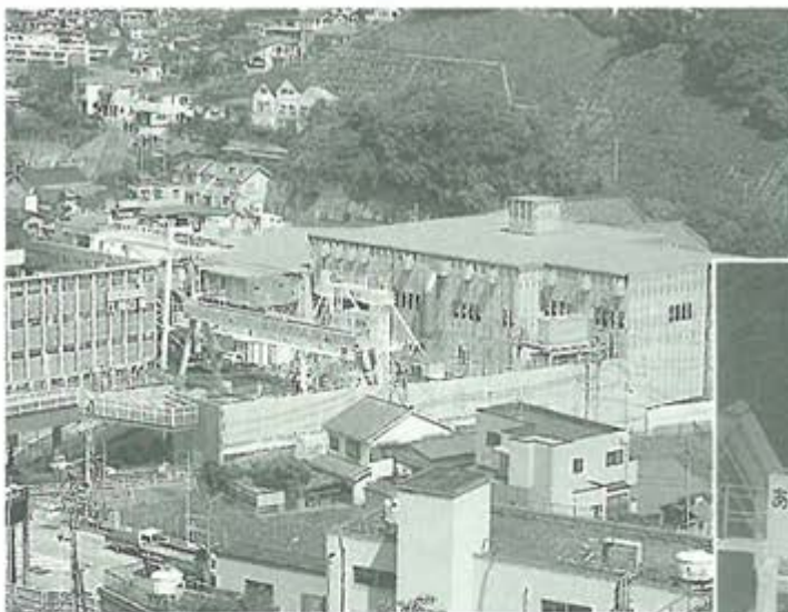
◀今井川地下調節池の工事基地では、周辺地域への影響に配慮した環境保全対策に万全を期している
