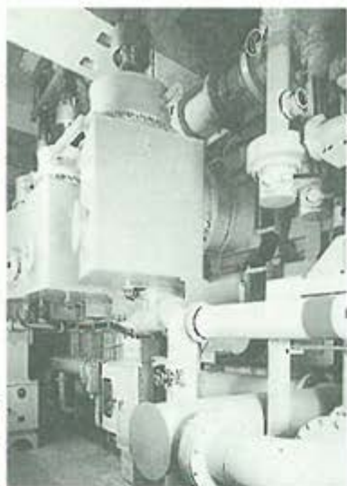
▲重量のある主要変圧器は最深部に当たる地下7階に設置されている
