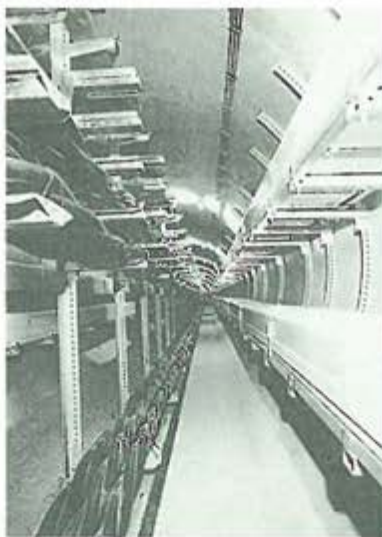
▲洞道（地下トンネル）を通過して、27万5千ボルトの電気が高輪変電所に送られる
