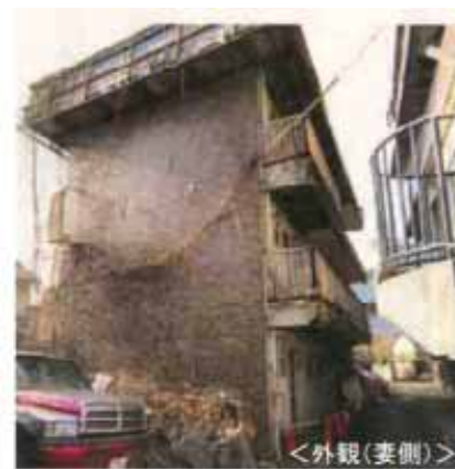
外壁、手すりが崩落した事例
