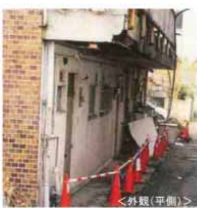
外壁、手すりが崩落した事例
