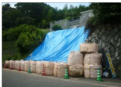
避難路を保全する土留工・排水工
