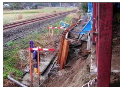
鉄道を保全する土留工
