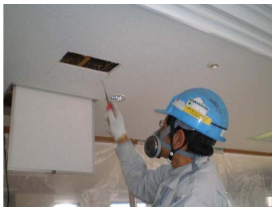
空調換気設備の改修（アスベスト処理）
