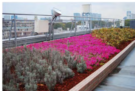
高輪東誠ビル屋上
