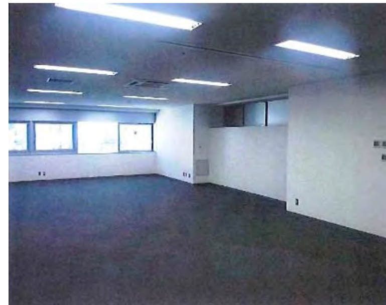
排煙窓の新設
