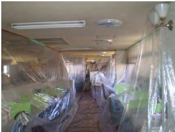
空調換気設備の改修（アスベスト処理）
