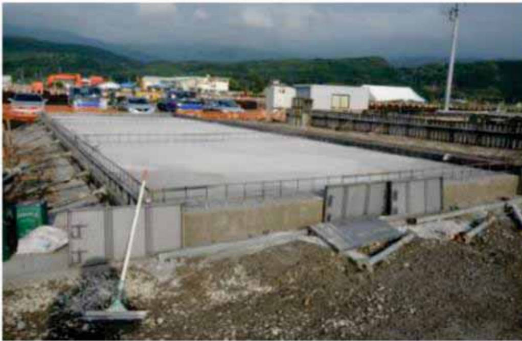
熊本県西原村に建設中の木造仮設住宅の基礎
