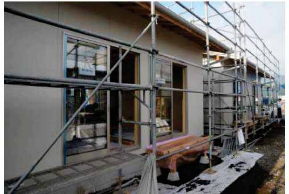
熊本県西原村に建設中の木造仮設住宅
